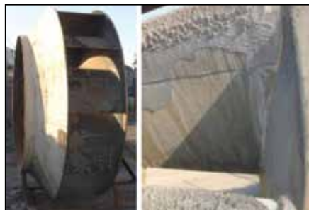
Build-up on fan blades.
