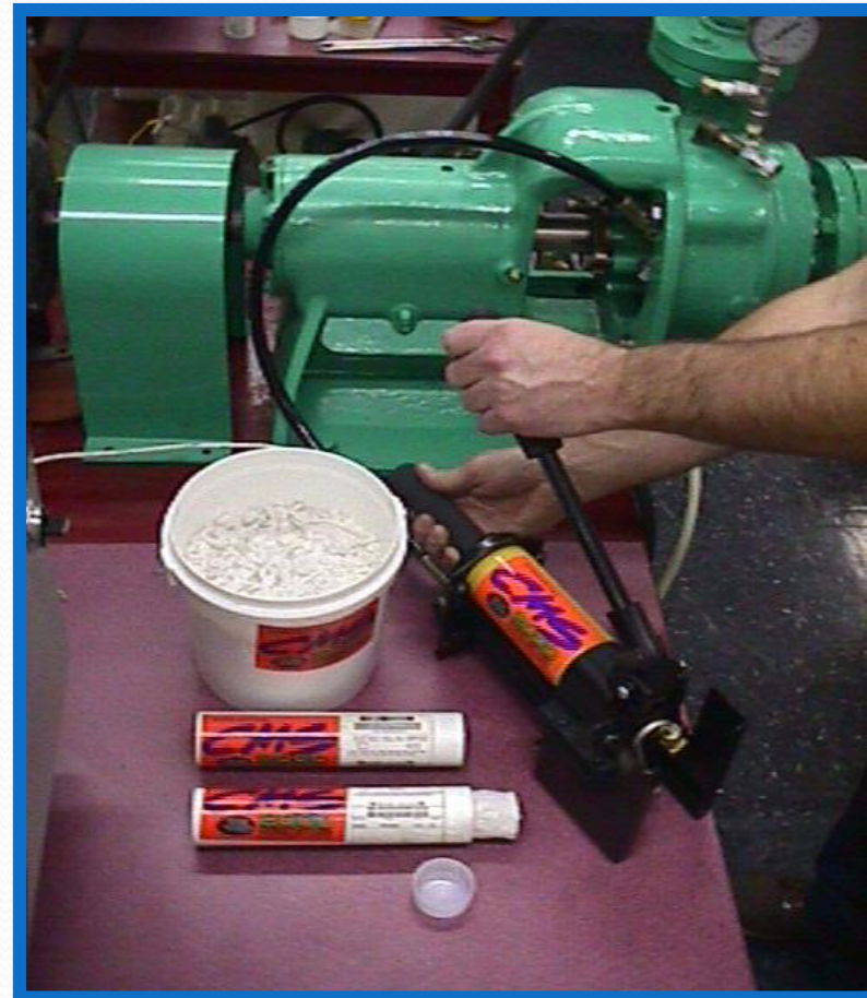
Injeção de gaxeta com a bomba em operação
